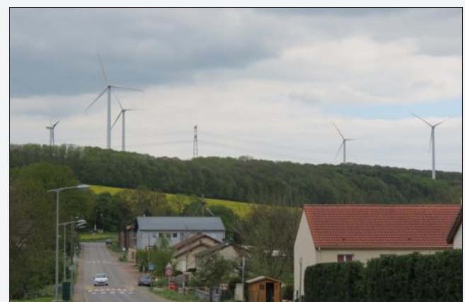
Vue sur les éoliennes de Téterchen depuis le village de Brettnach. Photo RL/Nicolas THIERCY
